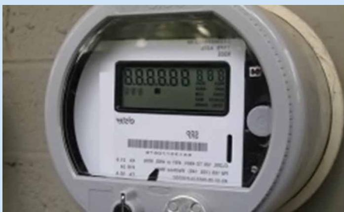
Прикладом застосування підходу покращення контролю за технологічними показниками є встановлення лічильників та запровадження обліку енергоресурсів на окремих ділянках виробництва на підприємстві з виготовлення пластмасових виробів медичного призначення у м. Білгород-Дністровський.
